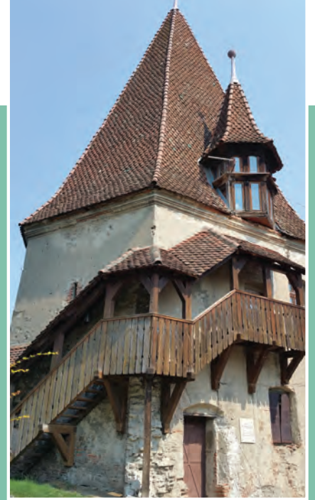
Turnul Cizmarilor - zidul de incintă al Sighișoarei
