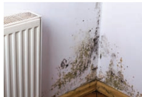
Fig. 11 – Mucegai pe un perete cu umezeală crescută
