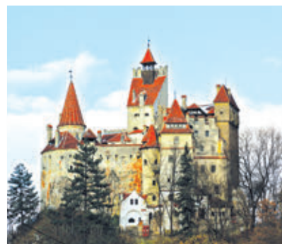
Fig. 3 – Castelul Bran – construit pentru a supraveghea principalul drum comercial dintre Țara Românească și Transilvania
