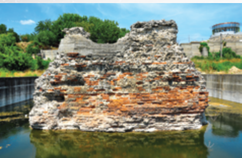
Fig. 12 – Piciorul podului de peste Dunăre pe care au trecut legiunile romane în 105 d.Hr., construit de Apolodor din Damasc
