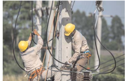
Fig. 23 Electricieni de rețele electrice
