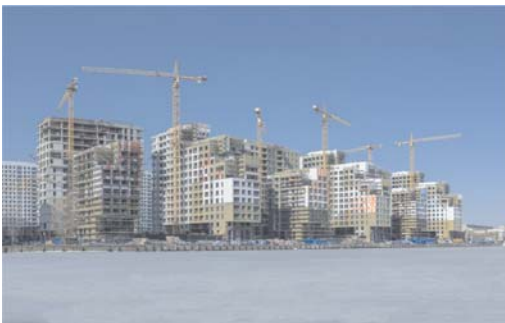
Fig. 14 Realizarea suprastructurii unei construcții
