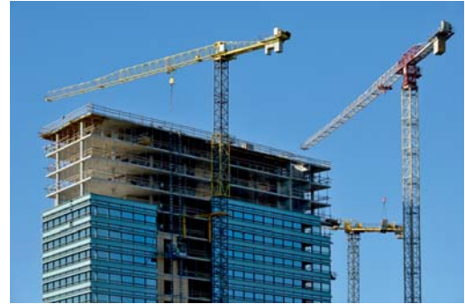
Fig. 16 Construirea unei clădiri, etapa de compartimentare și închidere
