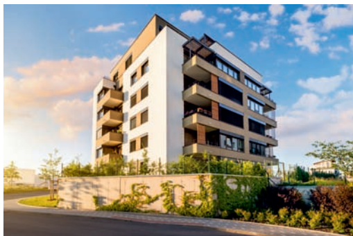
Fig. 3 Bloc de locuințe
