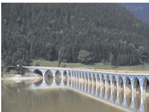
Fig. 2 Viaduct, Poiana Teiului, Bicz, România
